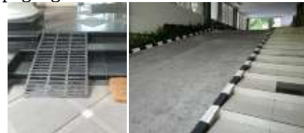
Gambar 4. Ramp (kiri : AHC, kanan :UI)
